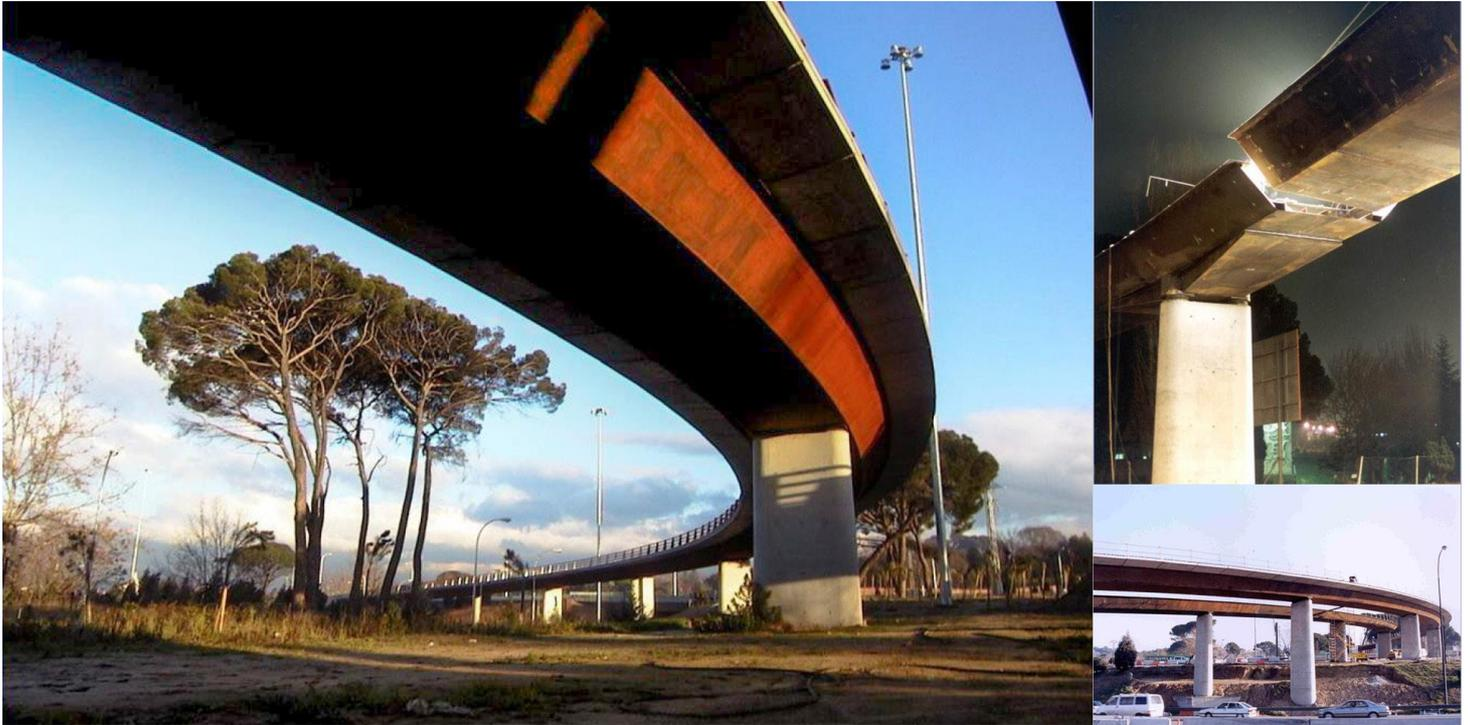
Esta estructura está compuesta de dos viaductos paralelos de 413,17 m y de 265,17 m de longitud total, respectivamente, que parten de la N-VI y pasan sobre la M-30 y la propia N-VI. Los vanos normales tienen luces próximas a los 25,00 m, siendo el vano máximo, sobre la N-VI, de 40,00 m. El tablero es de canto constante, igual a 1,25 m, con acartelamientos en los apoyos del vano principal. Las pilas son fustes troncocónicos o pantallas, dependiendo de sus posibilidades de apoyo.
